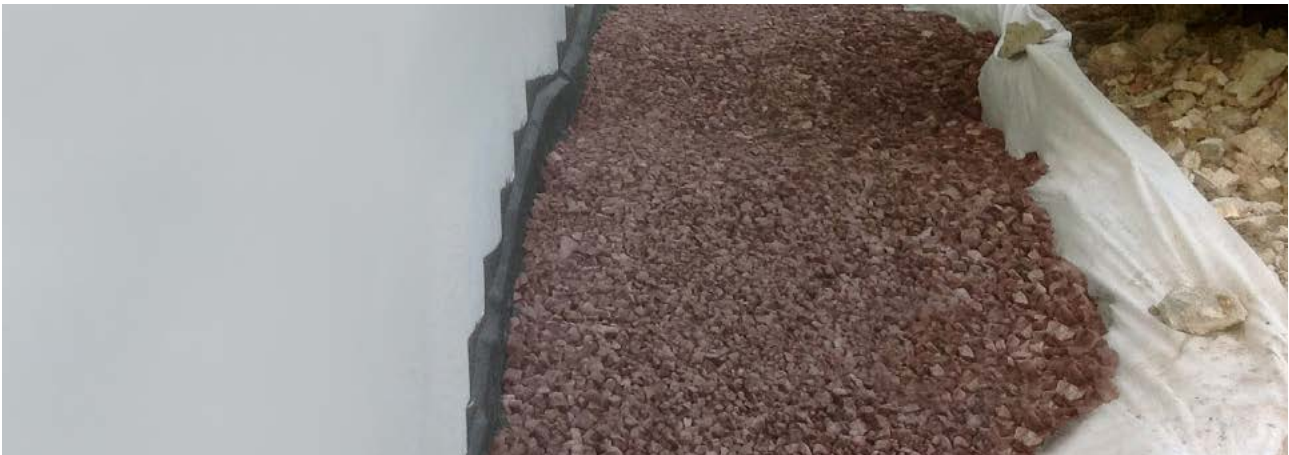
Opvullen van de werksleuf, laag voor laag verdichten van veriso RED geëxpandeerde glaskorrels
